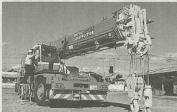
購入したラフタークレーン
